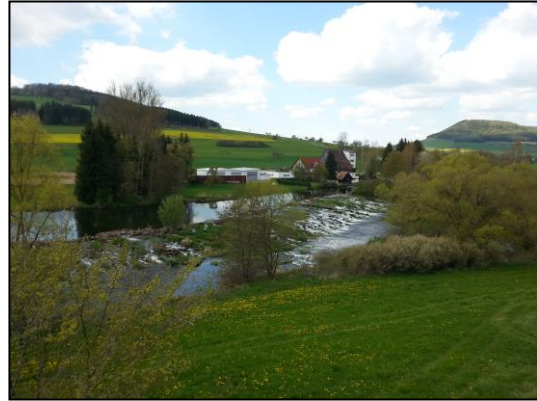
Bild: Zustand vor dem Umbau
